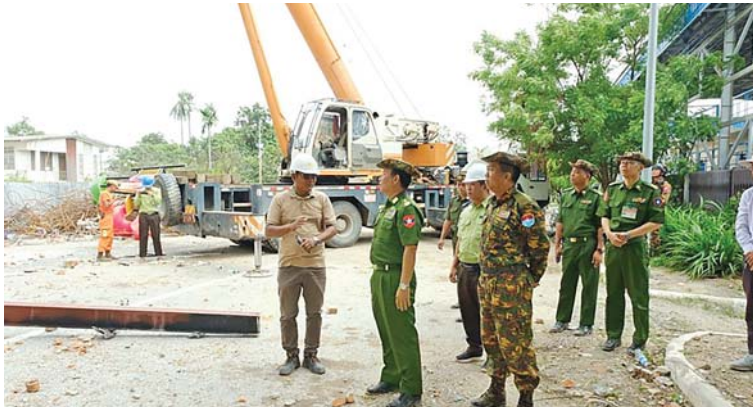
ကာကွယ်ရေးဦးစီးချုပ်ရုံး(ကြည်း)မှဒုတိယဗိုလ်ချုပ်ကြီးစိုးတင်နိုင် Sky Villa နေရာတွင် ငလျင်ဒဏ်ကြောင့်ထိခိုက်ပျက်စီးခဲ့သောရှင်းလင်းရန်ကျန်ရှိနေသည့် “A” အဆောင်အား စက်ယန္တရားကြီးများအသုံးပြု၍ ဖယ်ရှားရှင်းလင်းနေမှုကိုကြည့်ရှုစစ်ဆေးစဉ်။
