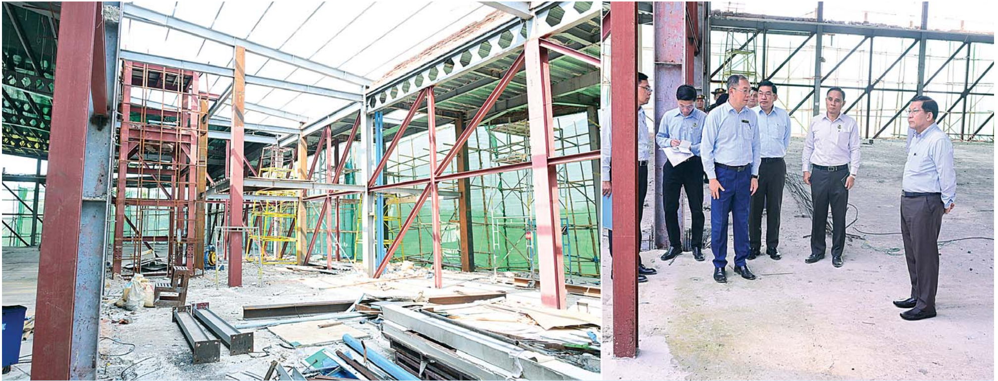
ပြည်ထောင်စုသမ္မတမြန်မာနိုင်ငံတော် နိုင်ငံတော်သမ္မတ ဦးမင်းအောင်လှိုင် မန္တလေးလျှောက်ကြောင့် ထိခိုက်ပျက်စီးမှုများဖြစ်ပေါ်ခဲ့သည့် မြန်မာ့ကျောက်မျက်ရတနာပြတိုက်(နေပြည်တော်)၌ပြန်လည်ပြင်ဆင် တည်ဆောက်ခြင်းလုပ်ငန်းများဆောင်ရွက်ထားရှိမှုအခြေအနေများကိုလှည့်လည်ကြည့်ရှုစစ်ဆေးစဉ်။
