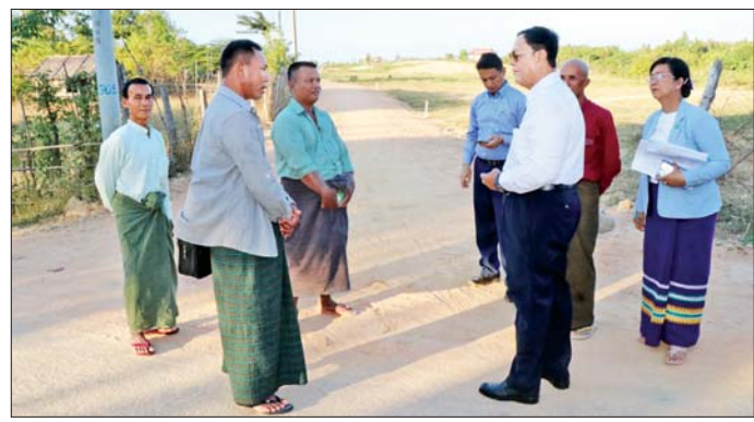
လမ်းဘေးဝဲယာ ရေမြောင်းများ တူးဖော်နေမှုကို လည်းကောင်း ကြည့်ရှုစစ်ဆေးပြီး ကျန်ရှိသော လမ်းပိုင်း ဆက်လက်ခင်းပေးနိုင်ရေး တင်ပြချက်အပေါ် လာမည့် ဘဏ္ဍာနှစ်တွင် လျာထားဆောင်ရွက်ပေးရန် တာဝန်ရှိသူများအား မှာကြားခဲ့ကြောင်း သိရသည်။
