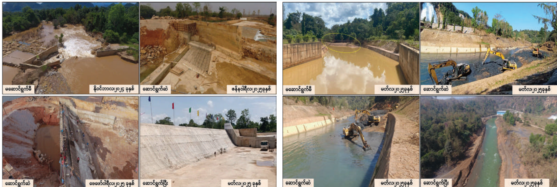
အလျား မီတာ ၆၀ x အနံ မီတာ ၃၀ x အမြင့် ၁၇ မီတာရှိ ရေလွှဲဆည်အမှတ်(၃) ဆောက်လုပ်ခြင်း သံကူကွန်ကရစ်လုပ်ငန်း (၉၀၄ ကျင်း) မှတ်တမ်းဓာတ်ပုံ။
