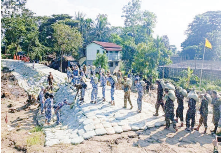
နယ်မြေခံတပ်မတော်သားများက ညောင်တုန်းကျွန်းတာ(ရောဝတီမြစ်ခွဲ)တာကိုယ် ထည်တိုက်စားခံရမှုတားဆီးကာကွယ်ရေးလုပ်ငန်းများ ဆောင်ရွက်ကြစဉ်။
