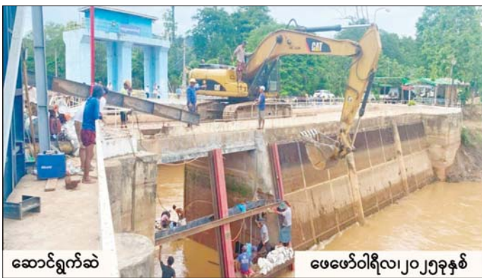
ဆောင်ရွက်ဆဲ အချိန်စစ်ဆန်ခါ ပြန်လည်ဖြုတ်ခြင်းလုပ်ငန်း ဆောင်ရွက်နေမှုကို တွေ့ရစဉ်။
