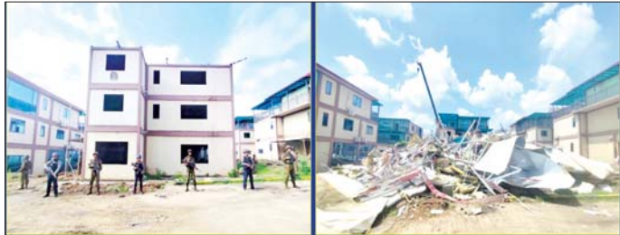
ကရင်ပြည်နယ် မြဝတီခရိုင် ရွှေကုက္ကိုလ်နယ်မြေ၌ အွန်လိုင်းလောင်းကစားလုပ်ငန်း လုပ်ကိုင်ခဲ့သည့် တရားမဝင် အဆောက်အအုံများအား မဖြိုဖျက်မီနှင့် မဖြိုဖျက်ပြီးနောက် တွေ့ရစဉ်။
