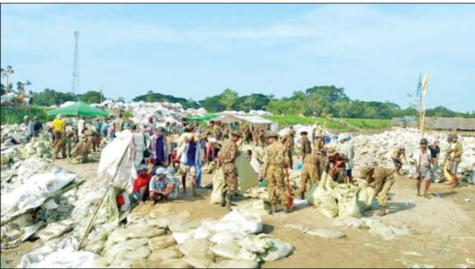
မျောတုတ်တန်းများအတွင်း သဲအိတ်များဖြည့်၍ ခြင်းစသည့် ငဝန့်ပန်းတာတမံ နိမ့်ကျနေရာများ ကာကွယ်ခြင်းနှင့် Steel Sheet Pile ရိုက်သွင်း ပြန်လည်ခိုင်မာရေးလုပ်ငန်းများကို လူအင်အား၊
