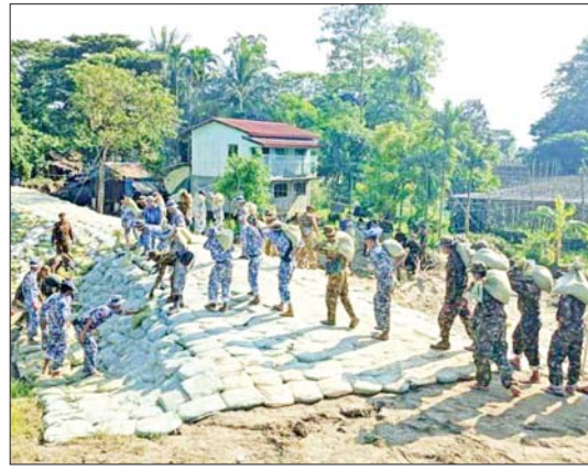
မျောတုတ်တန်းများအတွင်း သဲအိတ်များဖြည့်၍ ခြင်းစသည့် ငဝန့်ပန်းတာတမံ နိမ့်ကျနေရာများ ကာကွယ်ခြင်းနှင့် Steel Sheet Pile ရိုက်သွင်း ပြန်လည်ခိုင်မာရေးလုပ်ငန်းများကို လူအင်အား၊
