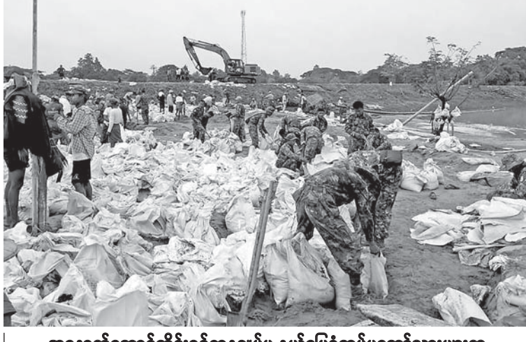
အနောက်တောင်တိုင်းစစ်ဌာနချုပ်မှ နယ်မြေခံတပ်မတော်သားများက ငဝန်ပန်းတာရေဝင်ရောက်မှုကို ထိန်းချုပ်ကာကွယ်နိုင်ရန်အတွက် မျောတုတ်တန်းများအတွင်း သဲအိတ်များဖြည့်၍ကာကွယ်ခြင်းဆောင်ရွက်ပေးစဉ်။
