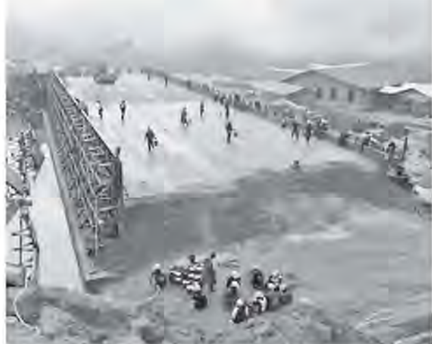
RCC Full Scale Trial Test(Test Slab) ပြုလုပ်နေပုံ (အထက်ပေါင်းလောင်း)
