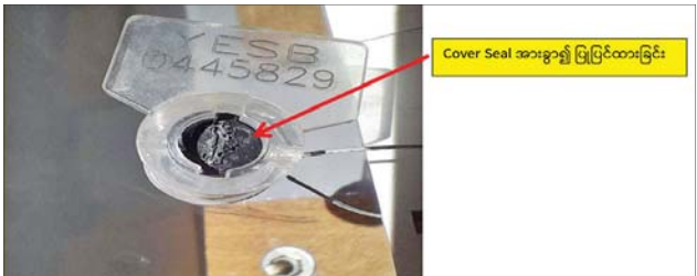
မှော်ဘီမြို့နယ် ဝါးနက်ချောင်းကျေးရွာရှိ မိတာအမည်ပေါက် ဦးစန်းဦး၏ ကော်စေ့လုပ်ငန်းတွင် အသုံးပြုထားသော Transformer နှင့် တွဲဖက်တပ်ဆင်ထားသည့် Digital Meter ၏ Cover Seal ပြုပြင်ထားသည့် မှတ်တမ်းဓာတ်ပုံများ။
